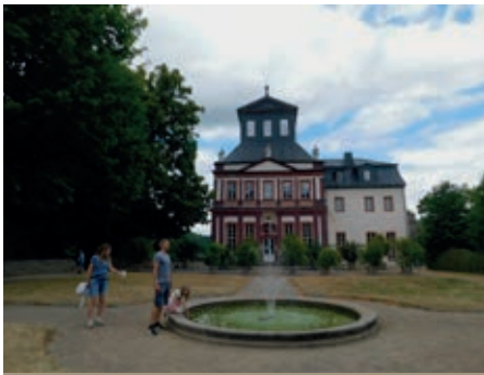
HINTER DIESER FASSADE verbirgt sich der berühmte Kaisersaal
