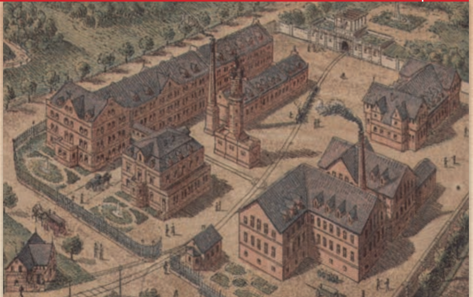
IM WESTEN VON RUDOLSTADT fand Richter den perfekten Platz für die Errichtung seiner Wunschfabrik, mit eigenem Elektrizitätswerk und Bahnhof
